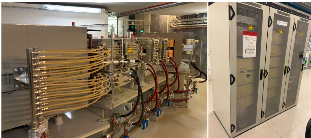
(陽子線治療装置/ (左:Scanditronix 社の電磁石、右:IECO社の高性能バイポーラ電源)
