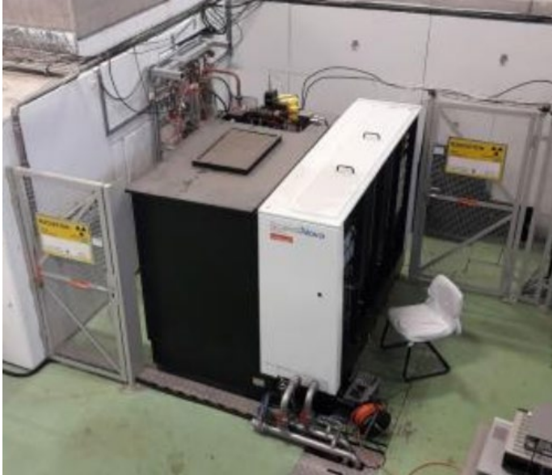
50 MW X-band RF power source (CERN, XBOX#2)
